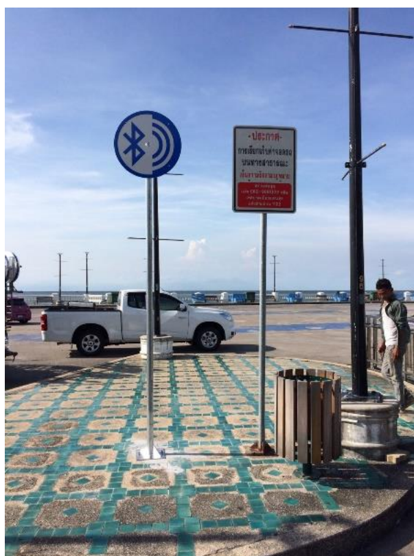
รูปที่ 4.1-27 ตำแหน่งการติดตั้ง blueBLE SignPost บริเวณแหลมแท่น (ลาน 2)
