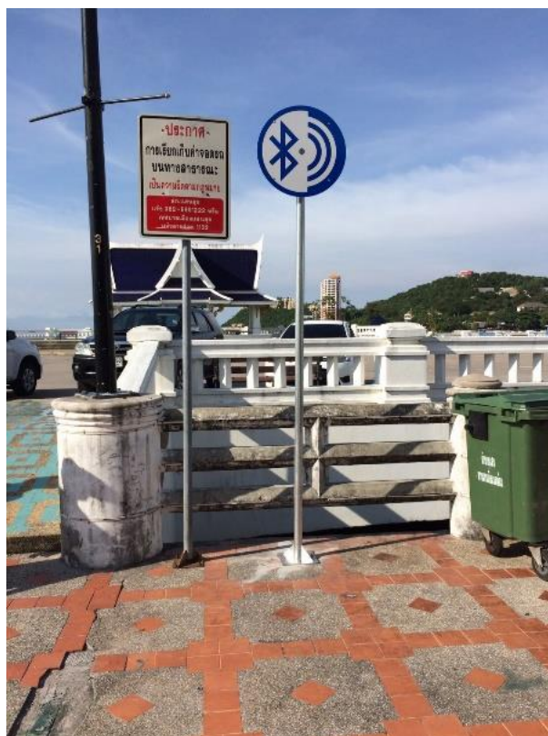
รูปที่ 4.1-26 ตำแหน่งการติดตั้ง blueBLE SignPost บริเวณแหลมแท่น (ลาน 1)
