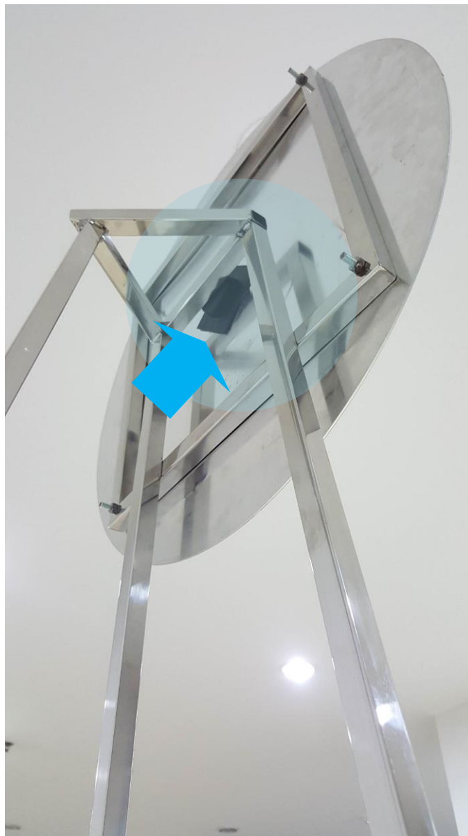
รูปที่ 4.1-19 ตำแหน่งการติดตั้งอุปกรณ์บีคอน (Beacon) บนป้ายสัญลักษณ์ blueBLE
