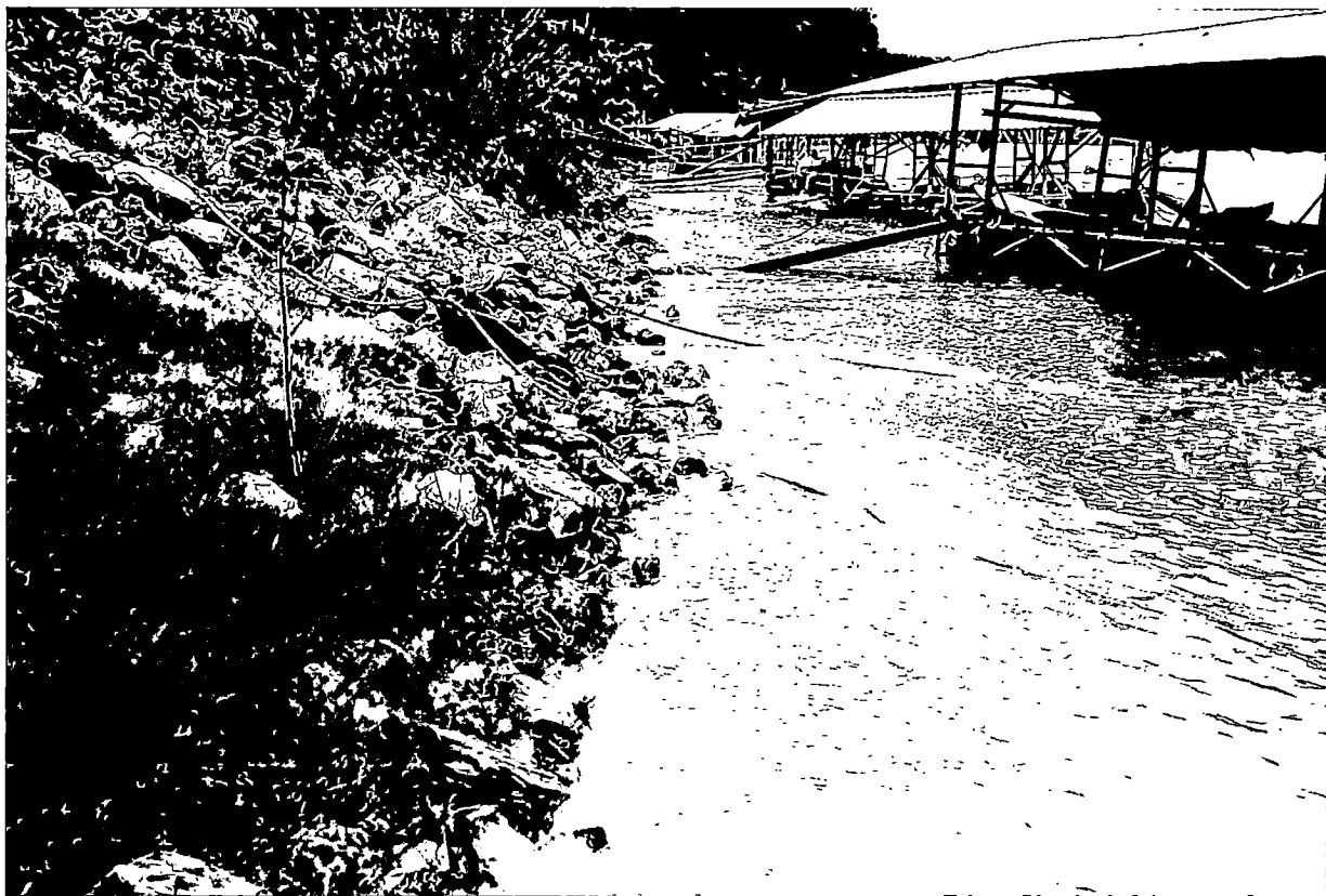
ภาพที่ 4.31 แสดงการวางหินเพื่อป้องกันการกัดเซาะตามแนวตลิ่งแม่น้ำโขงฝั่งไทยในพื้นที่ท่าเรือ อ.เชียงแสน จ. เชียงราย ภาพถ่ายเมื่อวันที่ 29 ตุลาคม 2016/2559
