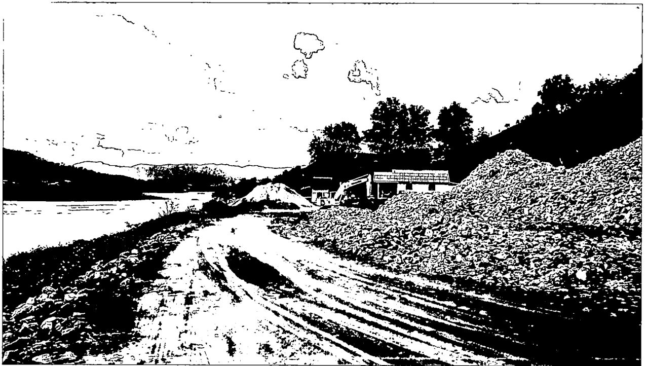
ภาพที่ 5.9 สภาพการทำงานผู้รับเหมาก่อสร้างในโครงการสร้างเขื่อนป้องกันตลิ่งริมแม่น้ำโขงด้วยวิธีการเรียงหิน ณ บ้านห้วยเอียน ตำบลห้วยยาว อำเภอเวียงแก่น จังหวัดเชียงราย (ภาพถ่ายเมื่อวันที่ 29 ตุลาคม 2559)
