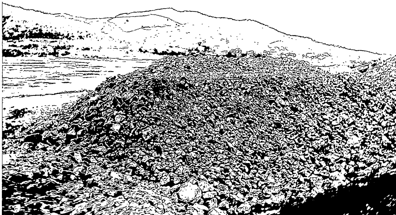
ภาพที่ 5.9 กองหินที่เตรียมใช้ในการสร้างเขื่อนป้องกันตลิ่งริมแม่น้ำโขงด้วยวิธีการเรียงหิน ณ บ้านห้วยเอียน ตำบลห้วยยาง อำเภอเวียงแก่น จังหวัดเชียงราย (ภาพถ่ายเมื่อวันที่ 29 ตุลาคม 2016/2559)
