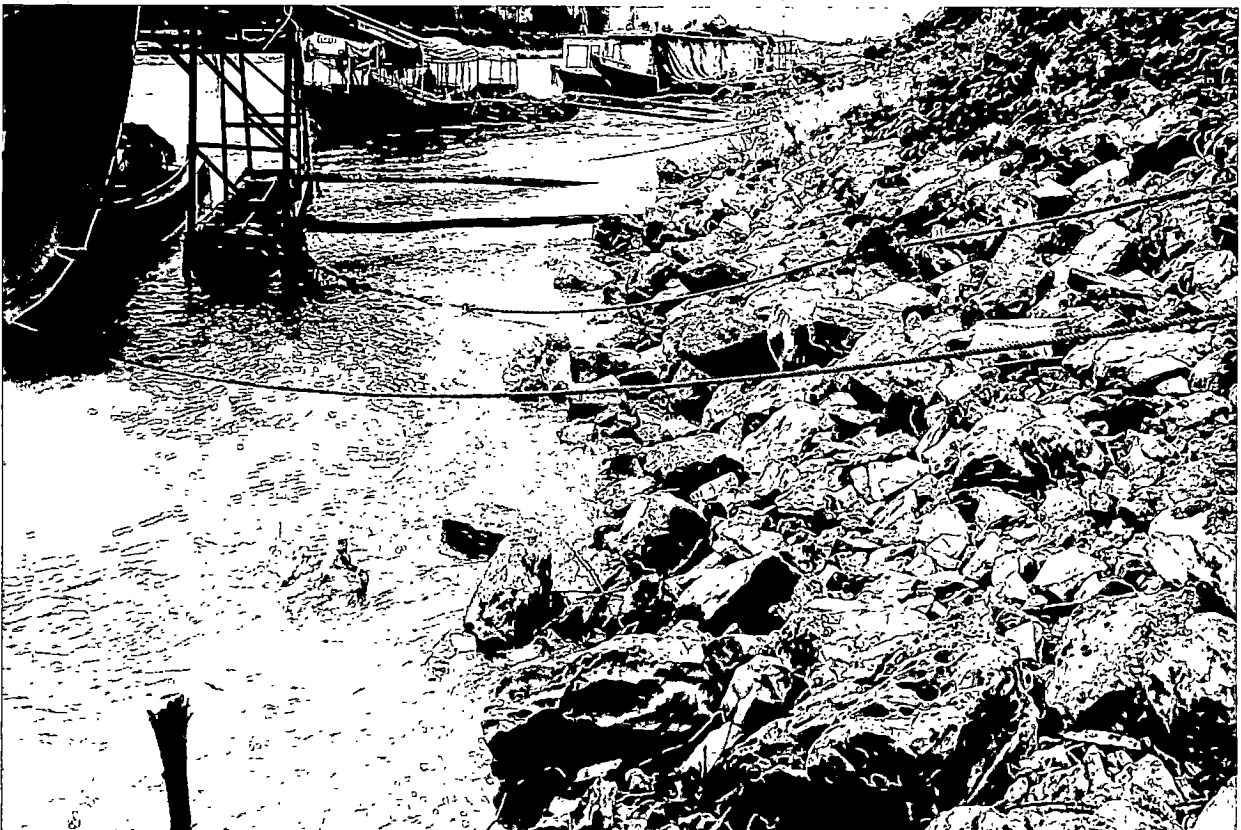
ภาพที่ 4.30 แสดงการวางหินเพื่อป้องกันการกัดเซาะตามแนวตลิ่งแม่น้ำโขงฝั่งไทยในพื้นที่ท่าเรือ อ.เชียงแสน จ. เชียงราย ภาพถ่ายเมื่อวันที่ 29 ตุลาคม 2016/2559
