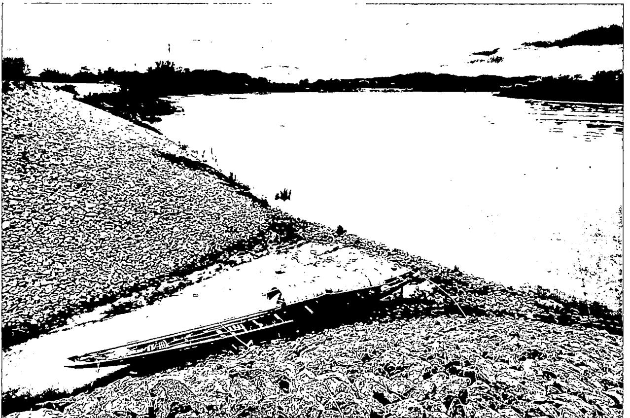
ภาพที่ 5.7 รูปแบบการสร้างเขื่อนป้องกันตลิ่งริมแม่น้ำโขงโดยการเรียงหินในพื้นที่โค้งแม่น้ำ ณ ตำบลเวียง อำเภอเชียงของ จังหวัดเชียงราย (ภาพถ่ายเมื่อวันที่ 29 ตุลาคม 2016/2559)
