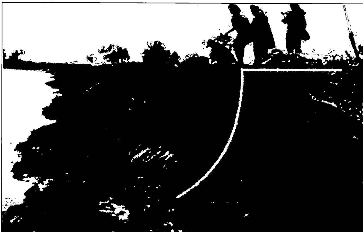
ภาพที่ 1.1 ตลิ่งแม่น้ำโขงที่พังทลายลงเนื่องจากถูกระแสน้ำกัดเซาะ ทำให้เกิดผลกระทบต่อประชาชนที่อาศัยอยู่ในบริเวณพื้นที่ตามแนวแม่น้ำโขง (ที่มา: หนังสือพิมพ์ไทยรัฐ 22 มีนาคม 2016/2559)
