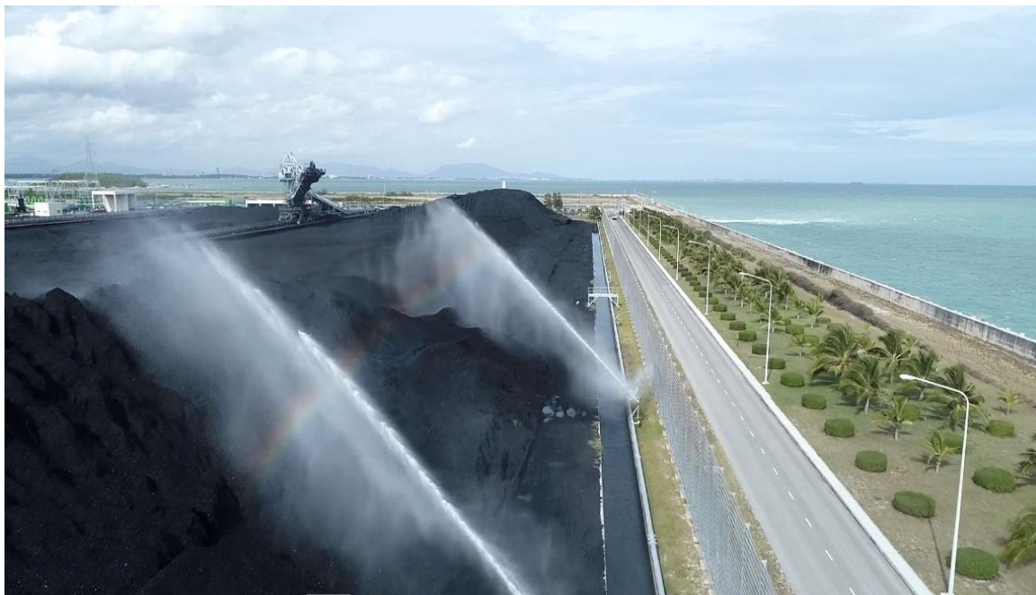
รูปที่ 6.1 ลานกองถ่านหินของบริษัท บีแอลซีพี เพาเวอร์ จำกัด
