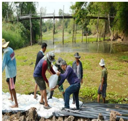
ภาพที่ 4.11 การทำฝายหินทั้งบ้านหมูสี ที่มา: องค์การบริหารส่วนตำบลพระพุทธ
