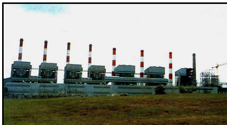
ภาพ 1.1 โรงไฟฟ้าแม่เมาะหน่วยการผลิตที่ 4 - 11 [2]
