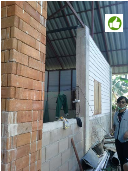
รูปที่ 4. ลักษณะความเสียหายของอาคารที่ได้รับความเสียหายประเภทที่ 1 โดยผนังคอนกรีตบล็อกพังถล่ม (Out-of-plane failure) และแนวทางการซ่อมแซมเบื้องต้น
